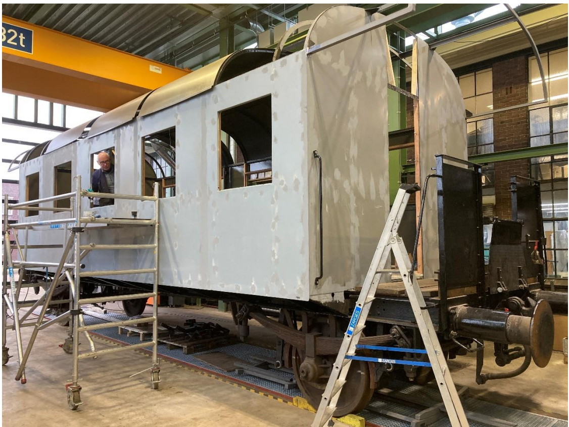
Rijtuig 59 is rondom opnieuw beplaat; het dak is binnenkort gereed.
