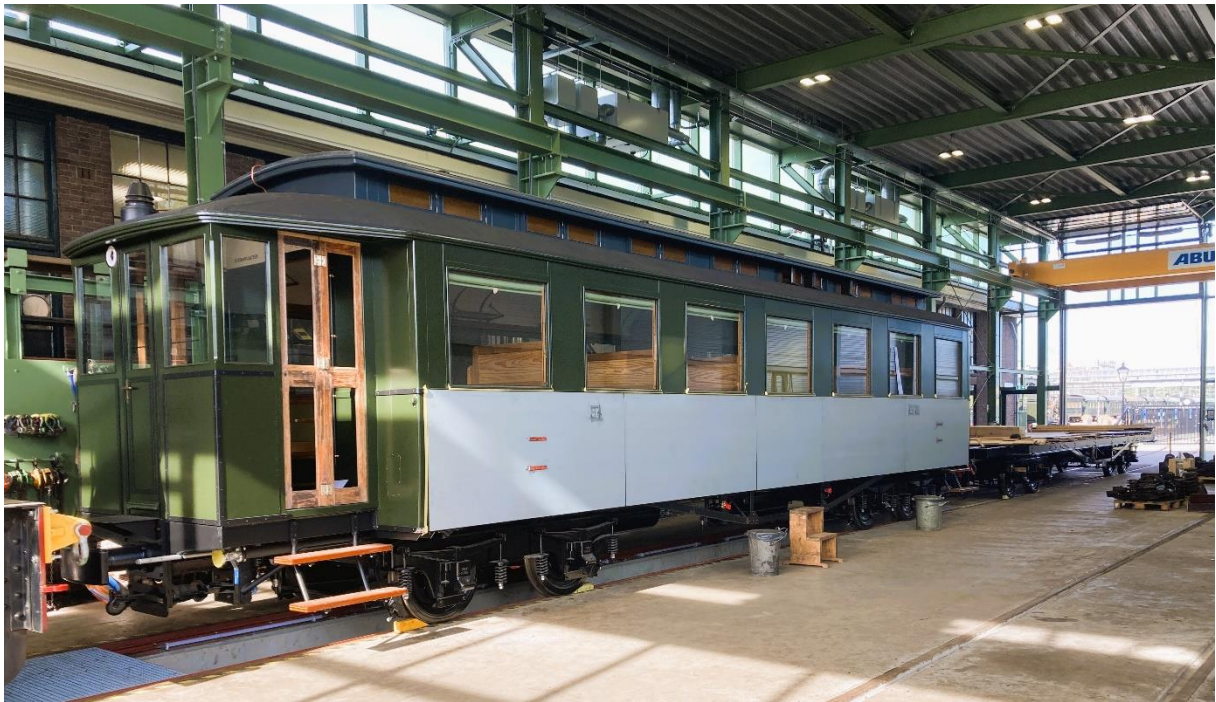
29 juni 2024: het plaatwerk is aangebracht op de houten bak van rijtuig 423.
