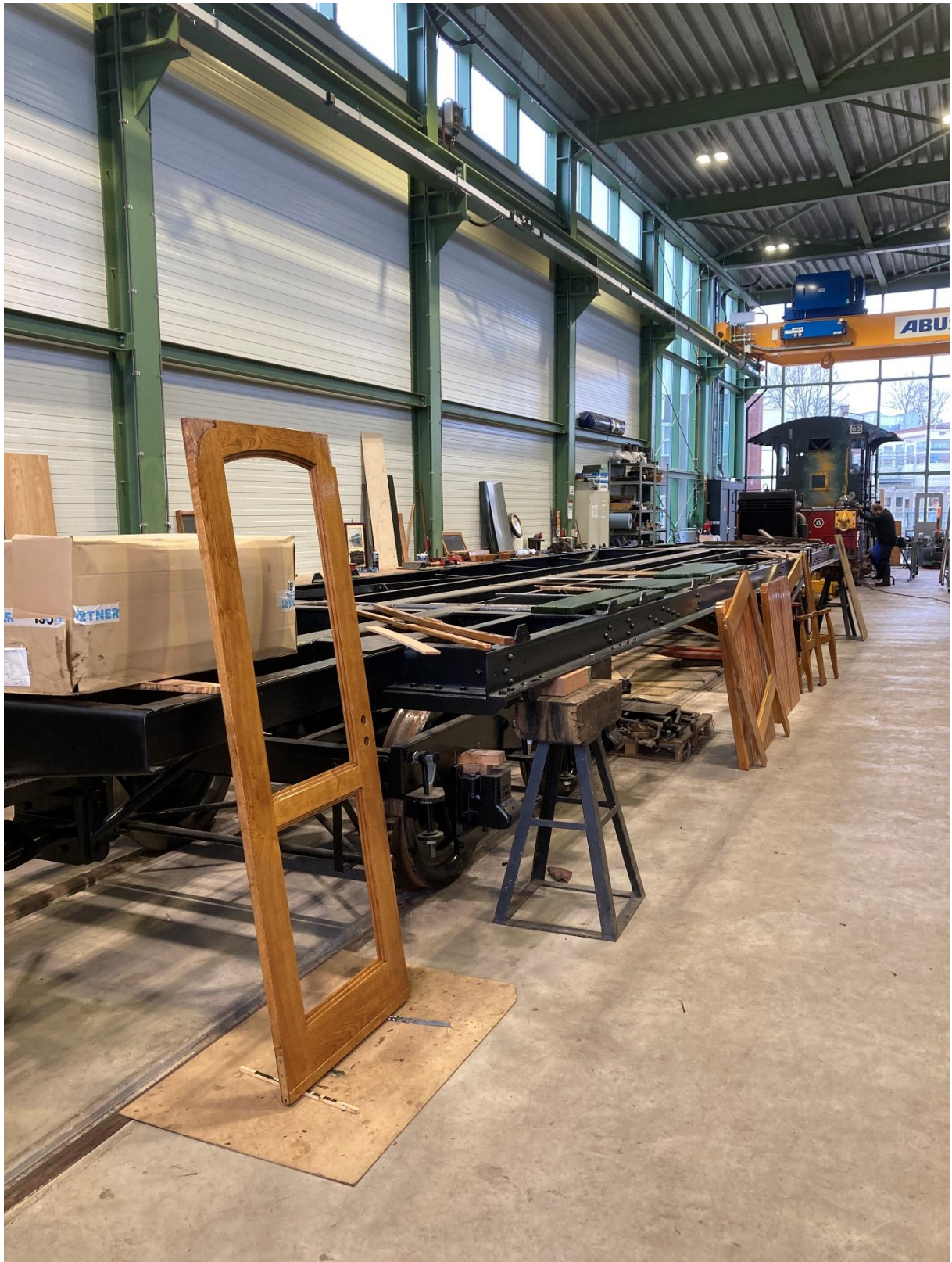
19 februari 2024: het onderstel met draaistellen voor Bello rijtuig 455 wordt voorzien van leidingen voor stoomverwarming, luchtdruk- en vacuümrem.
